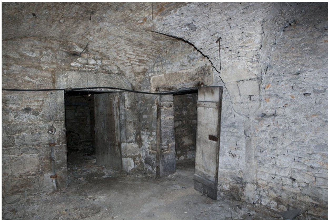
Logis principal, sous-sol : cave C.
