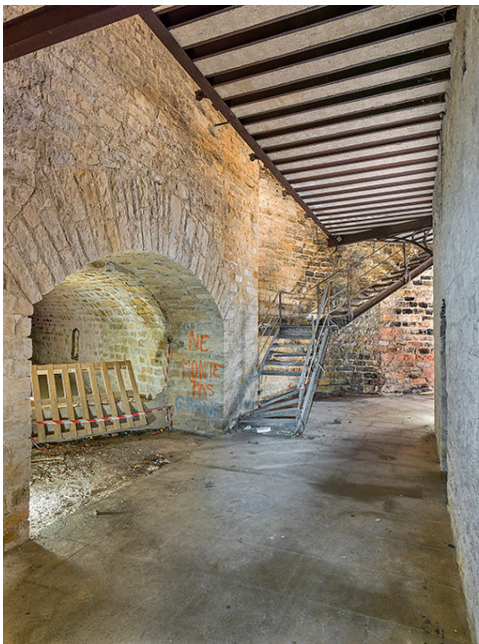
Escalier distribuant l'étage de la caserne.
