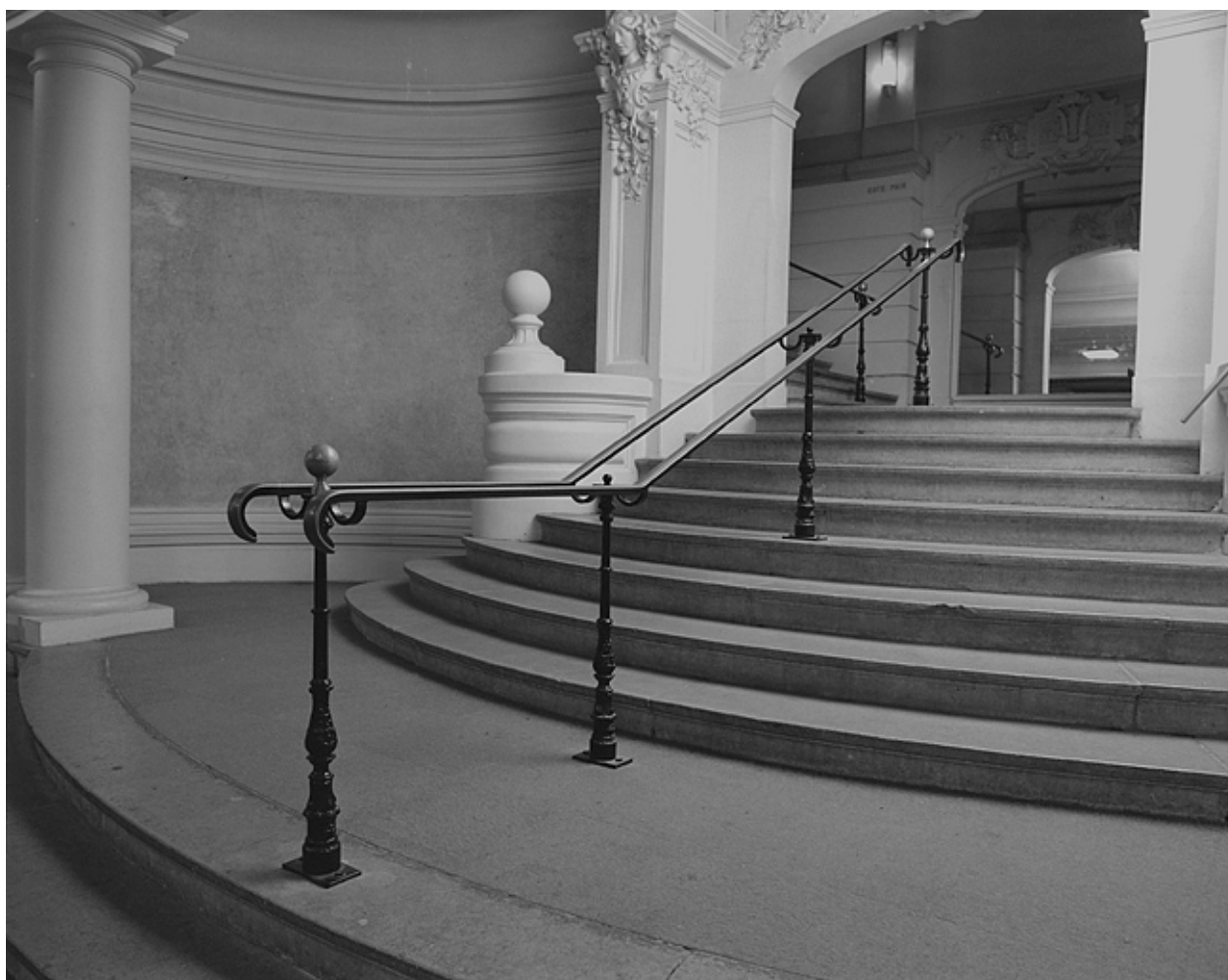
Grand escalier : détail.
