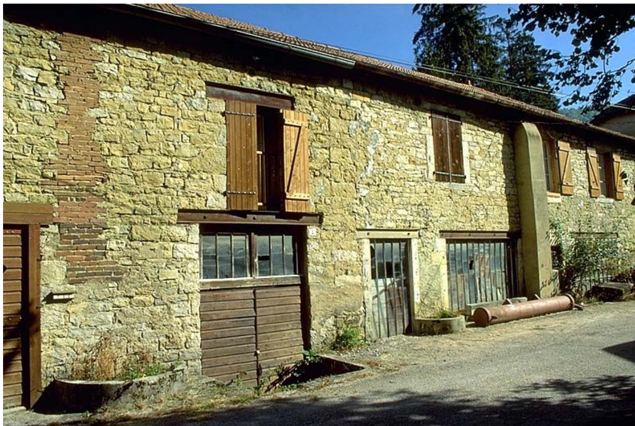
Façade antérieure de l'atelier de fabrication.
