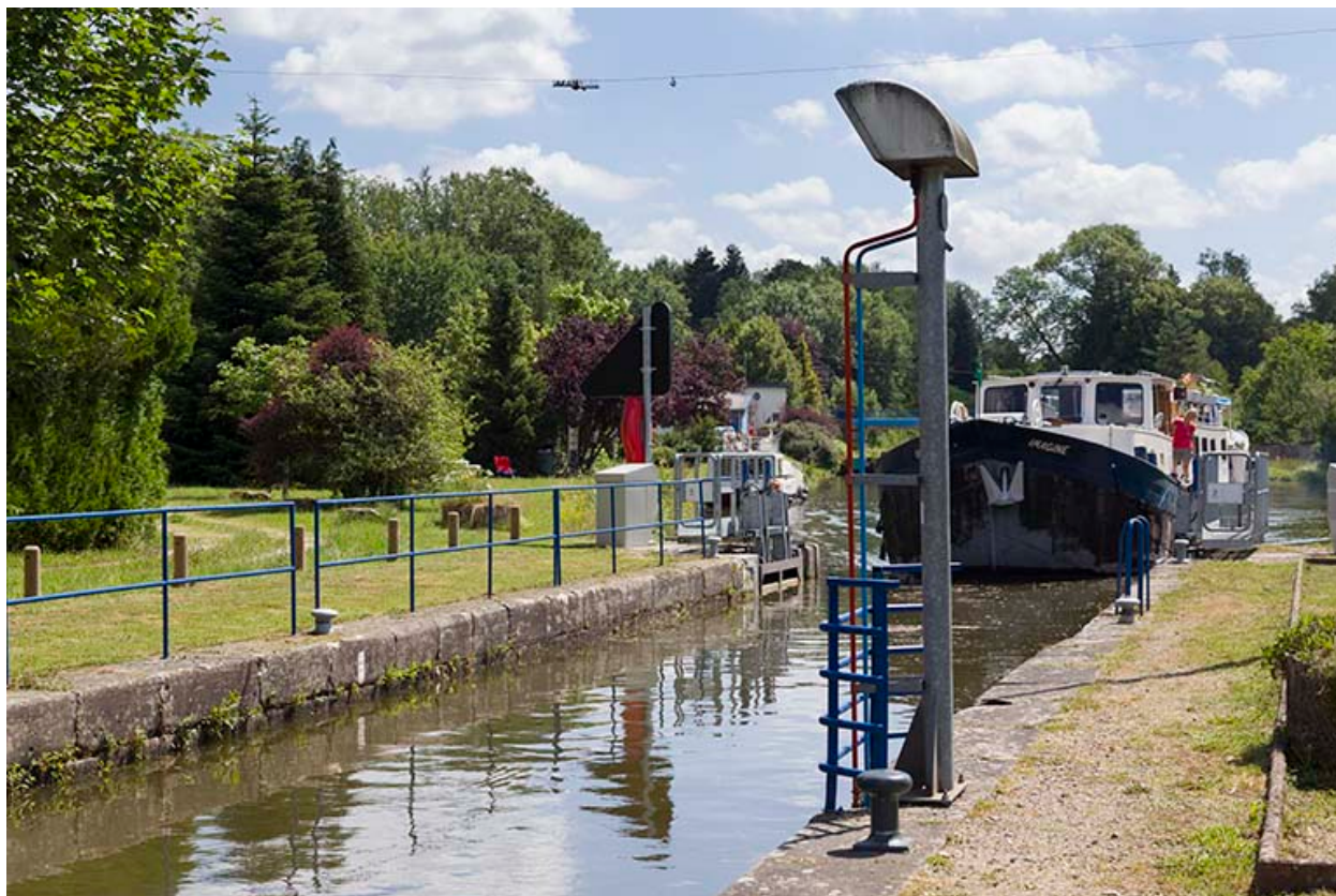
L'écluse de Pont-du-Bois.
