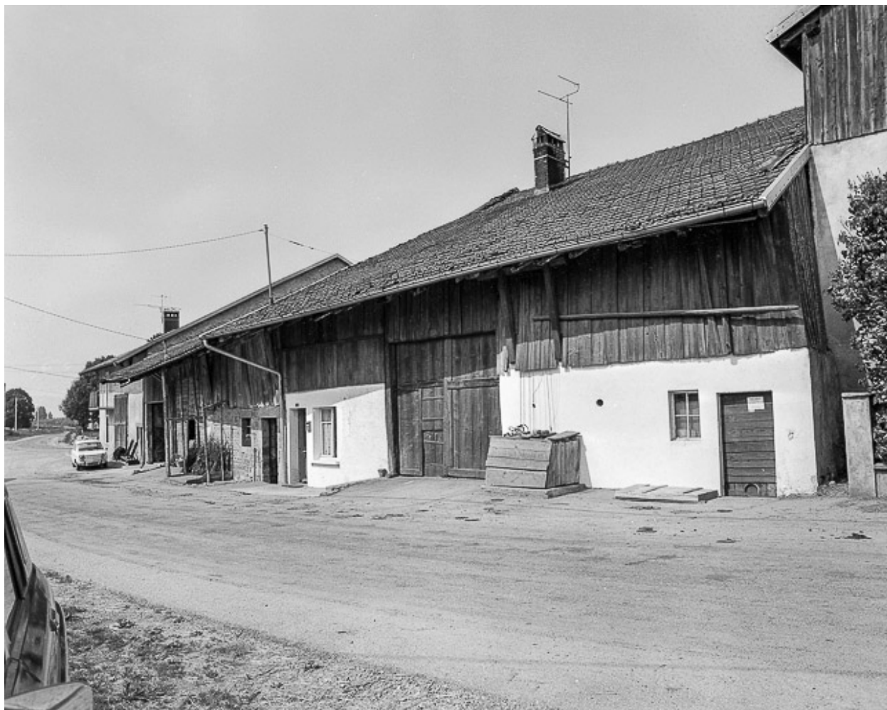
Ferme située rue de l'Ecole : façade antérieure.
