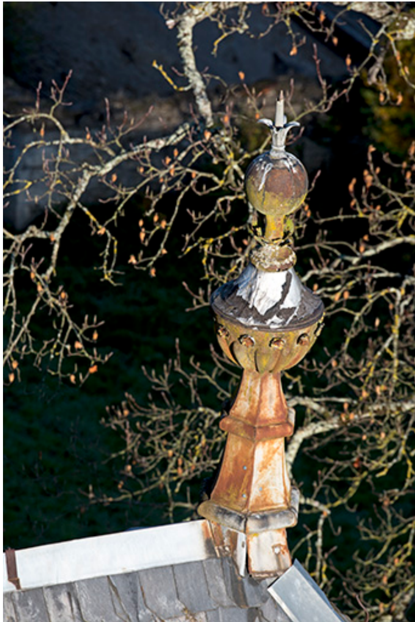
Détail : un des épis de faîtage.
