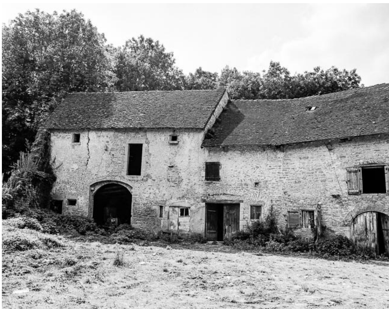
Partie agricole : façade sur cour.
