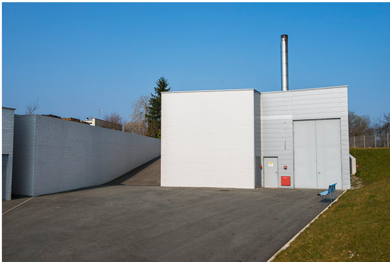
Façade postérieure sud de la chaufferie.
