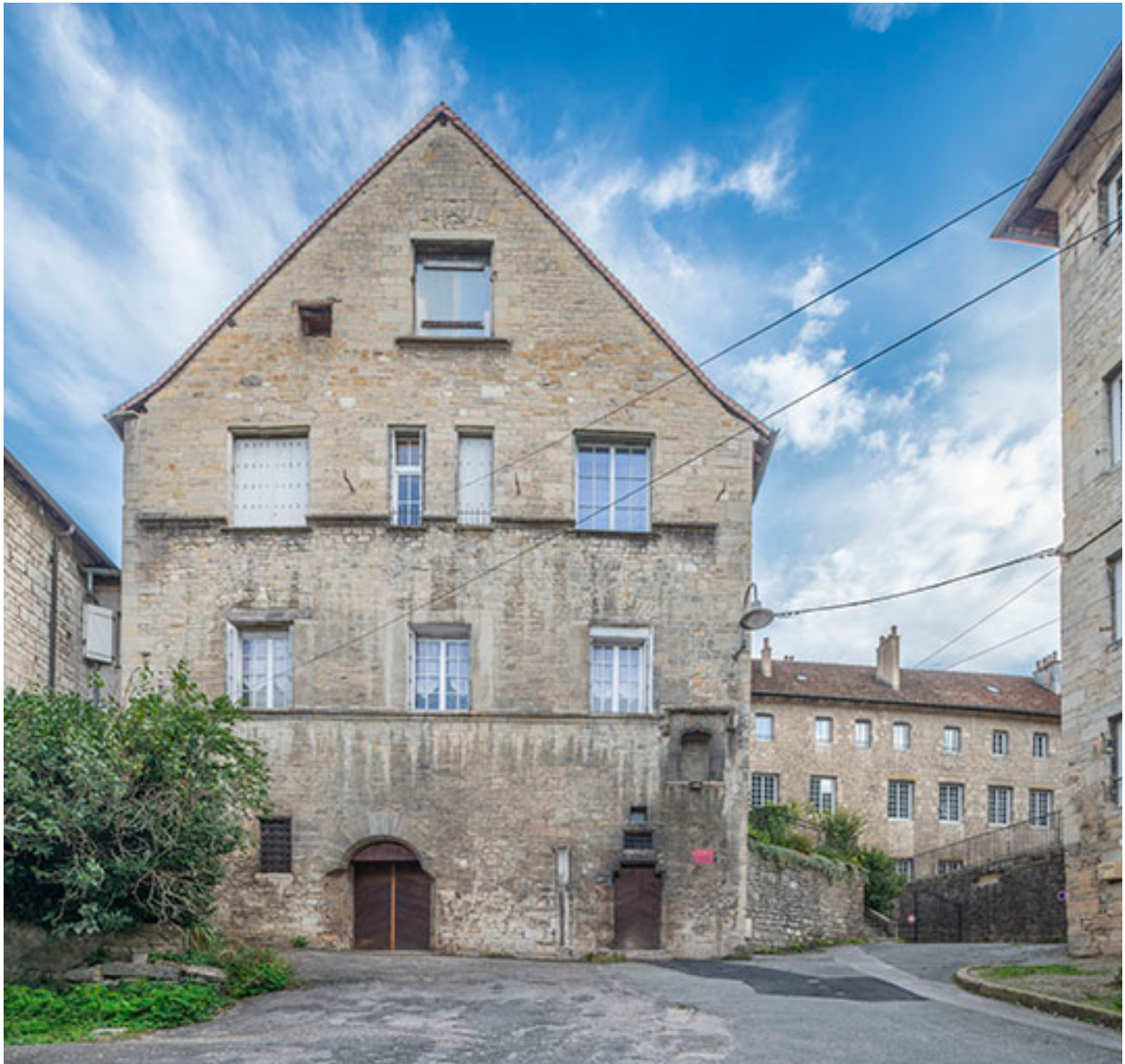
Façade ouest vue de face.
