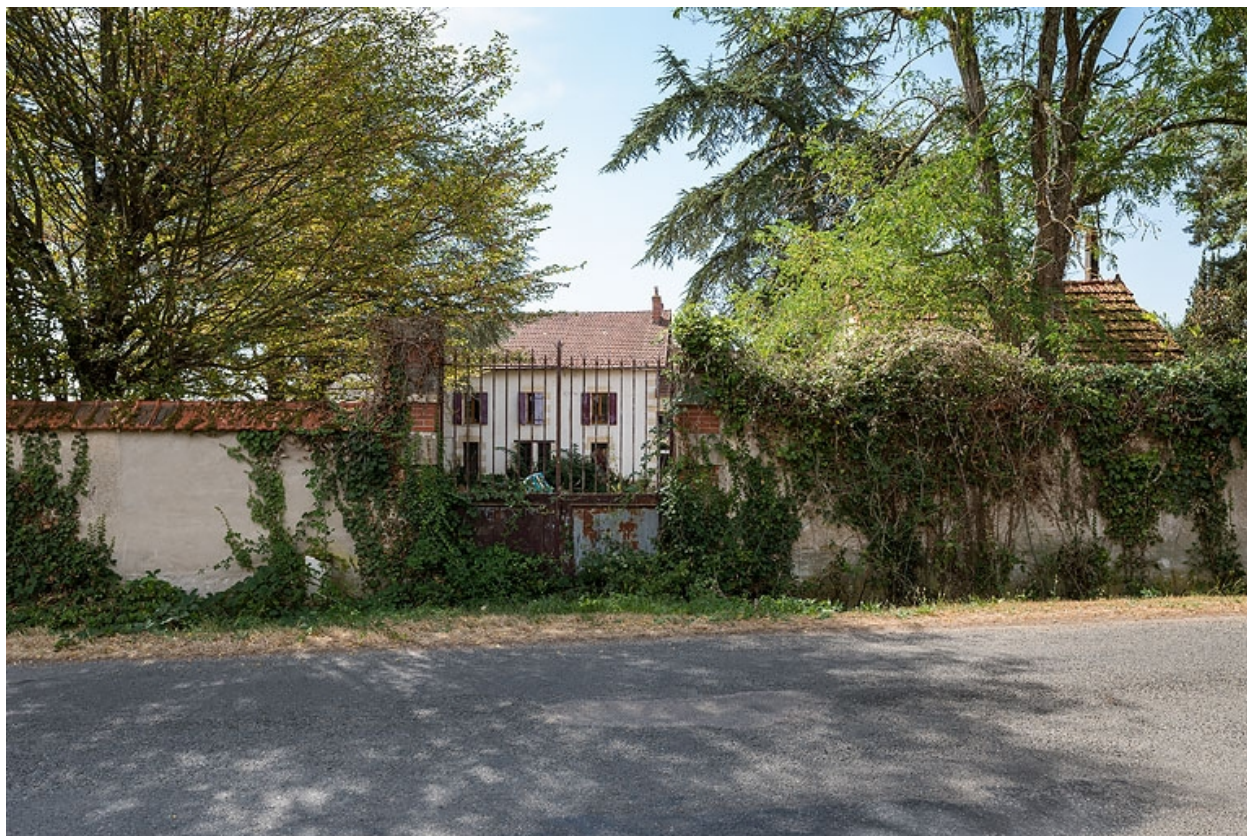
Portail d'entrée sur la rue des Fonts-Bouillants.
