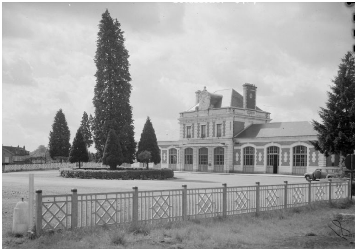
Façade, vue de trois quarts (vue ancienne).
