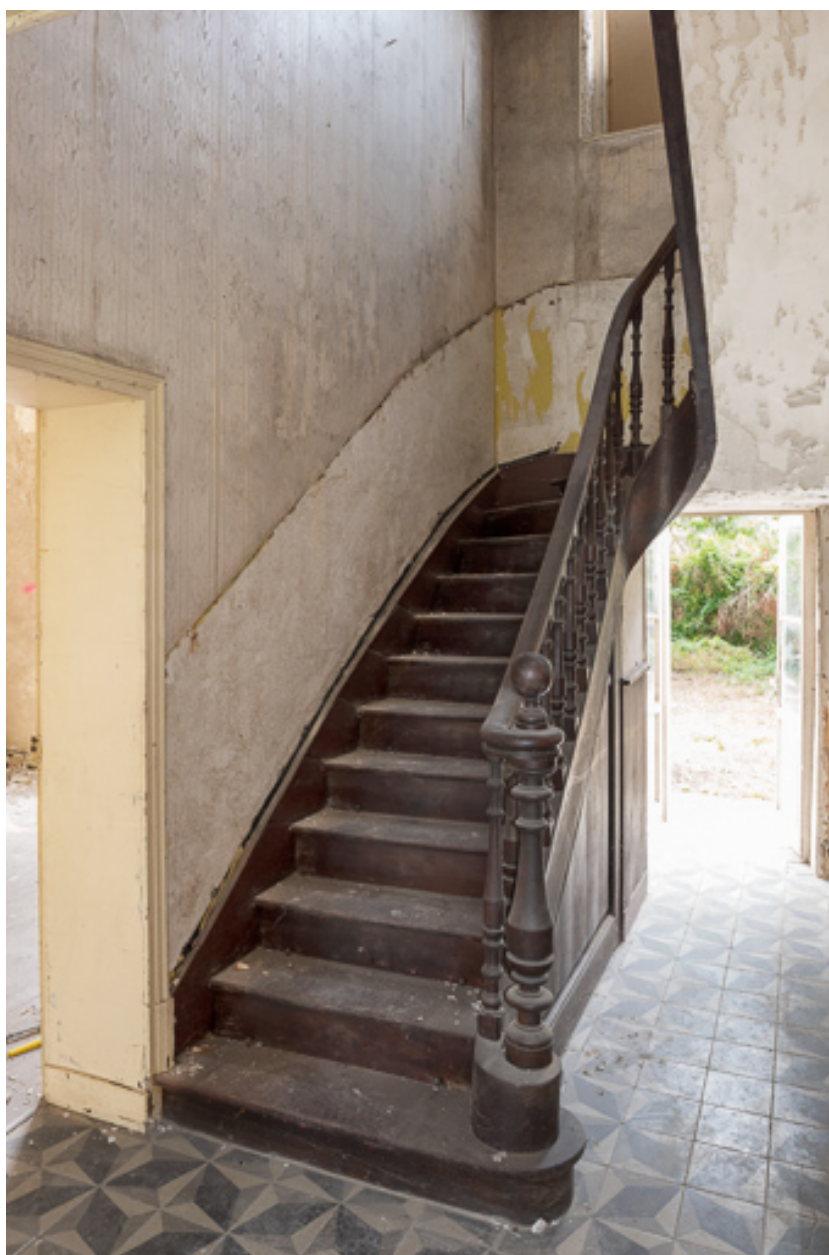
Escalier du corps principal, rez-de-chaussée.
