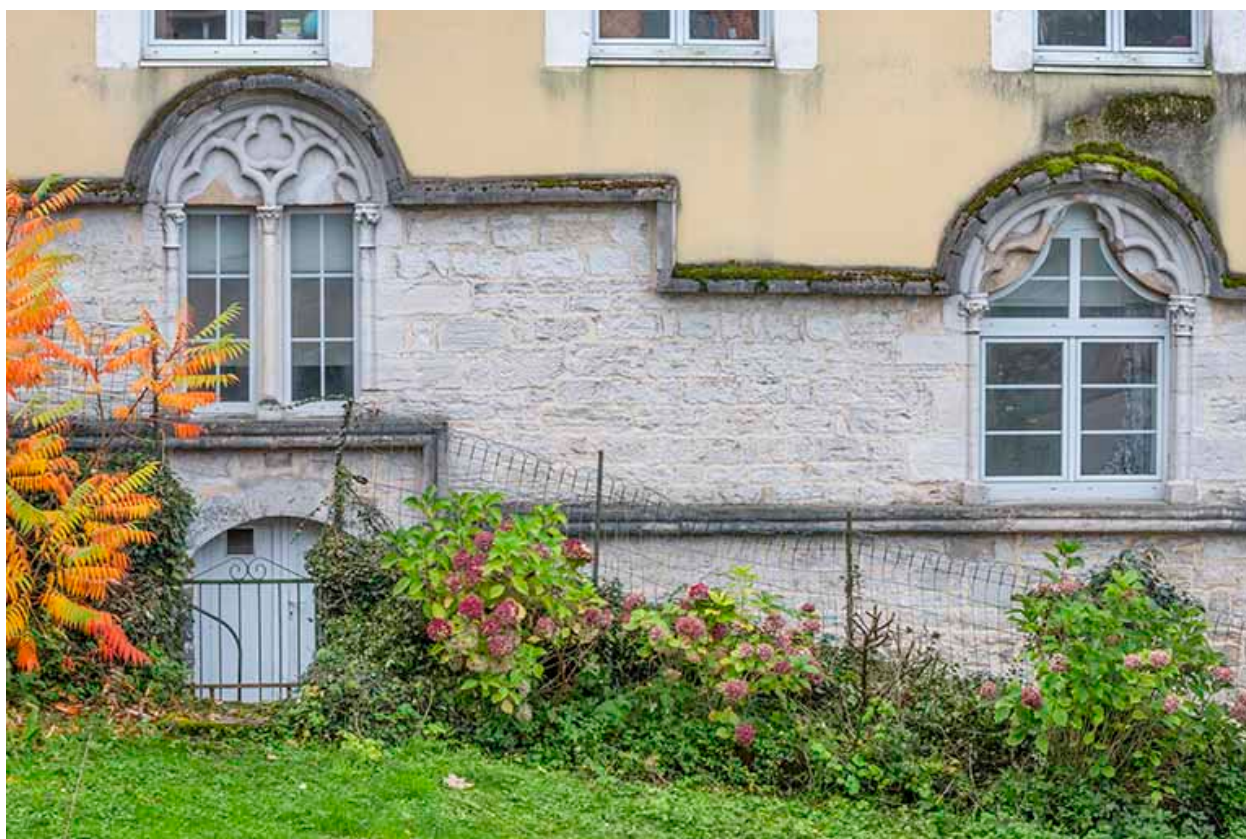
Fenêtres de la façade nord.
