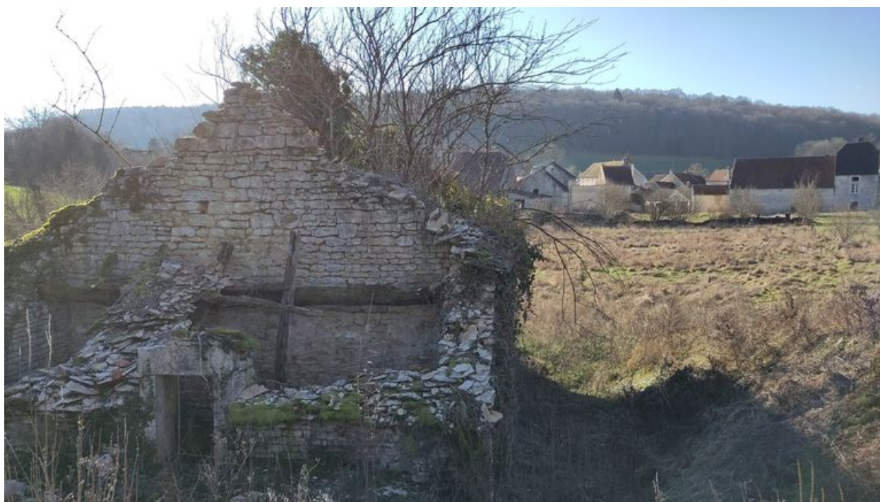
Vue du mur pignon nord du moulin et de l'extension adossée contre.
