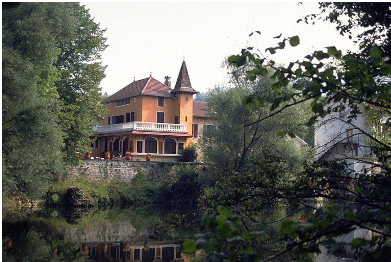
Logement patronal, depuis l'ouest.
