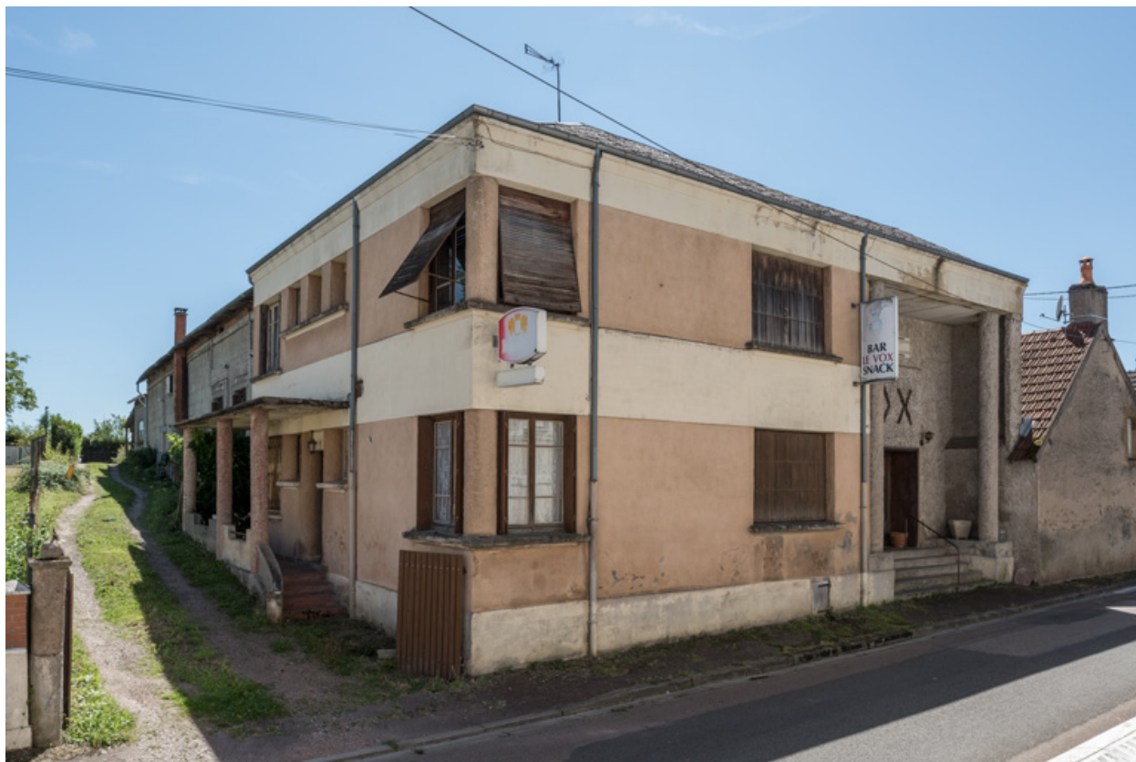
Façades antérieure et latérale gauche.
