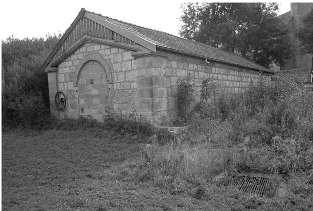
Fontaine, abreuvoir cadastrée 1972 AB 15 : vue générale.
