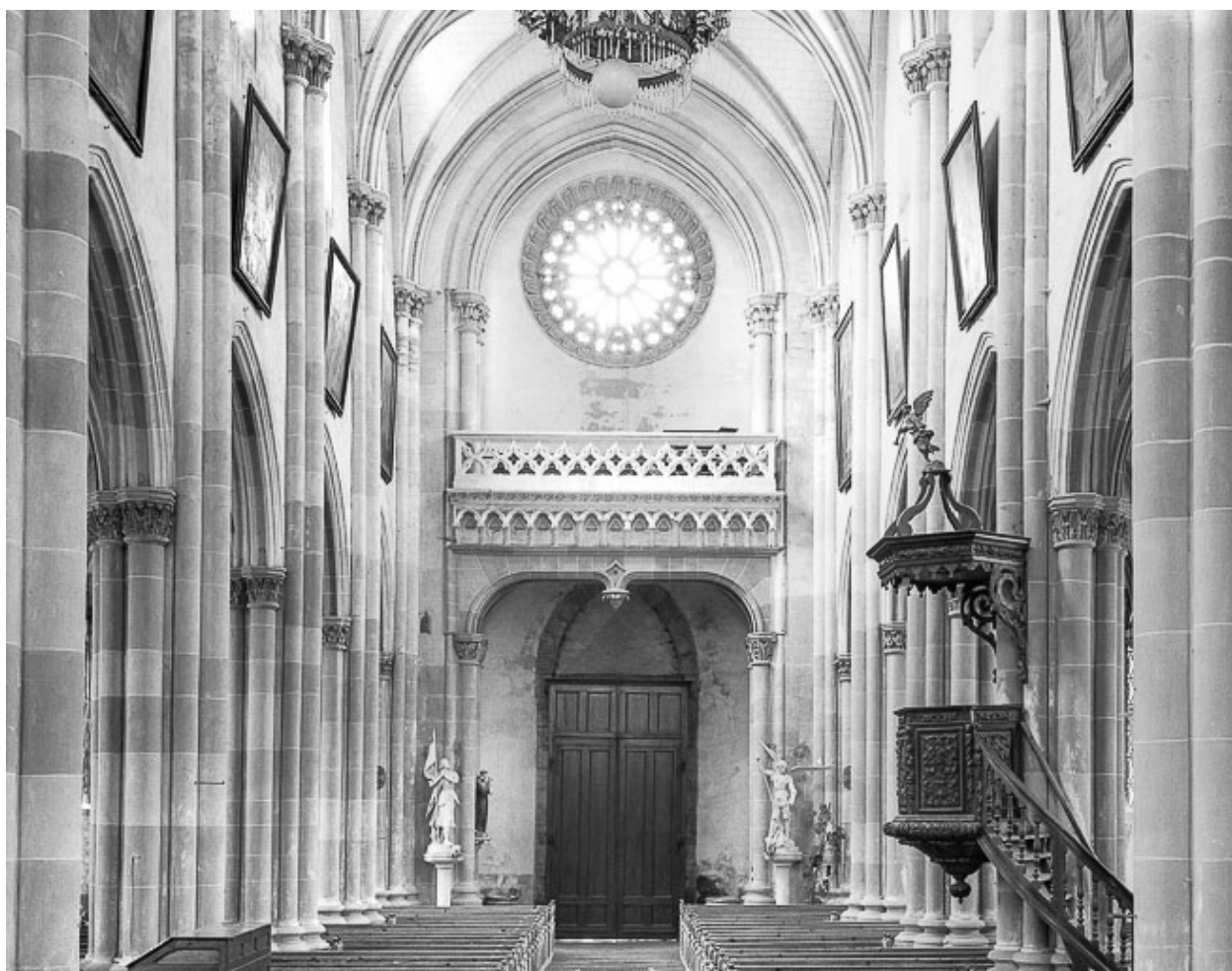
Nef vue depuis le chœur.
