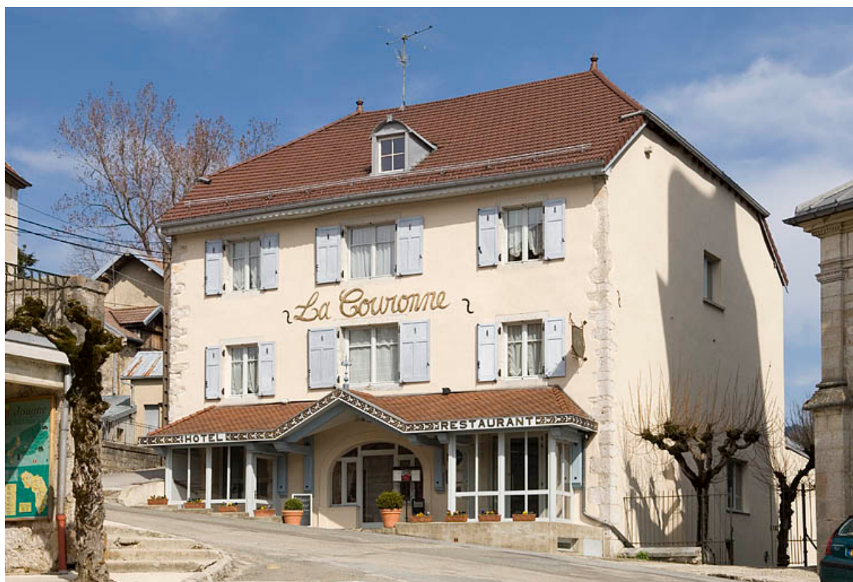
Façade antérieure et façade latérale droite.
