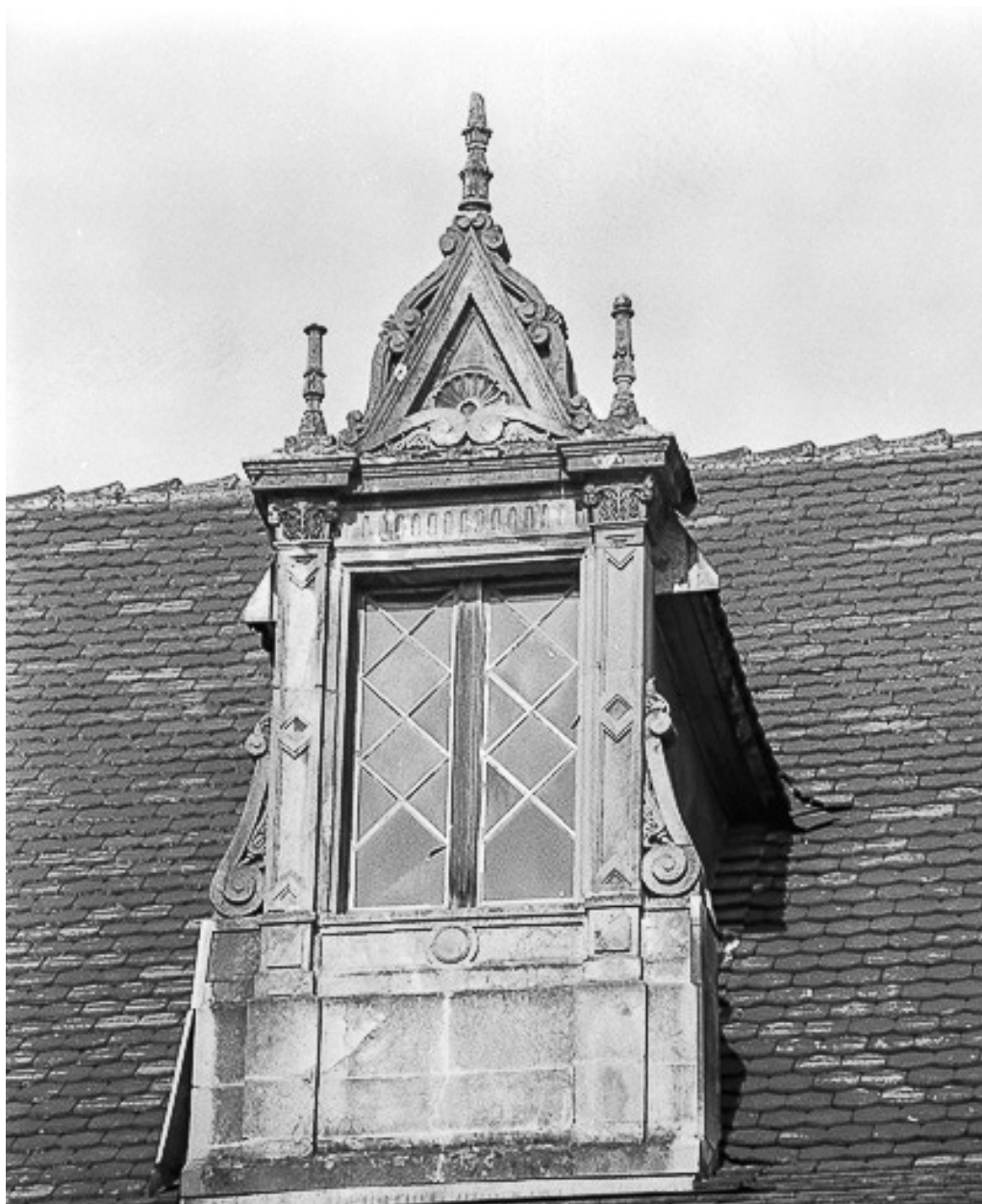
Façade sur rue, détail : lucarne.
