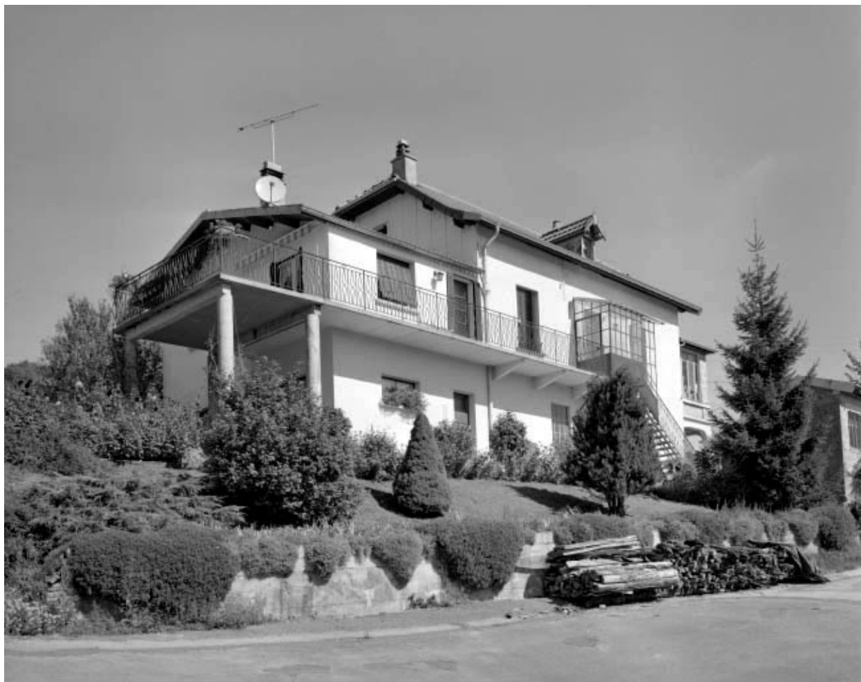
Vue en contre plongée du logement patronal.
