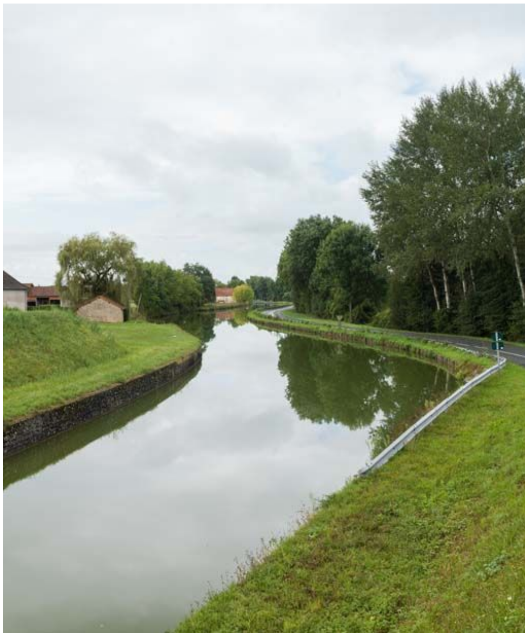
Vue d'ensemble du port.
