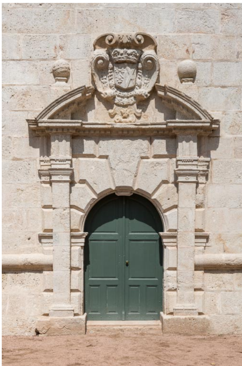
Façade sud-est, partie droite, mur d'écliffre du grand-degré, portail.
