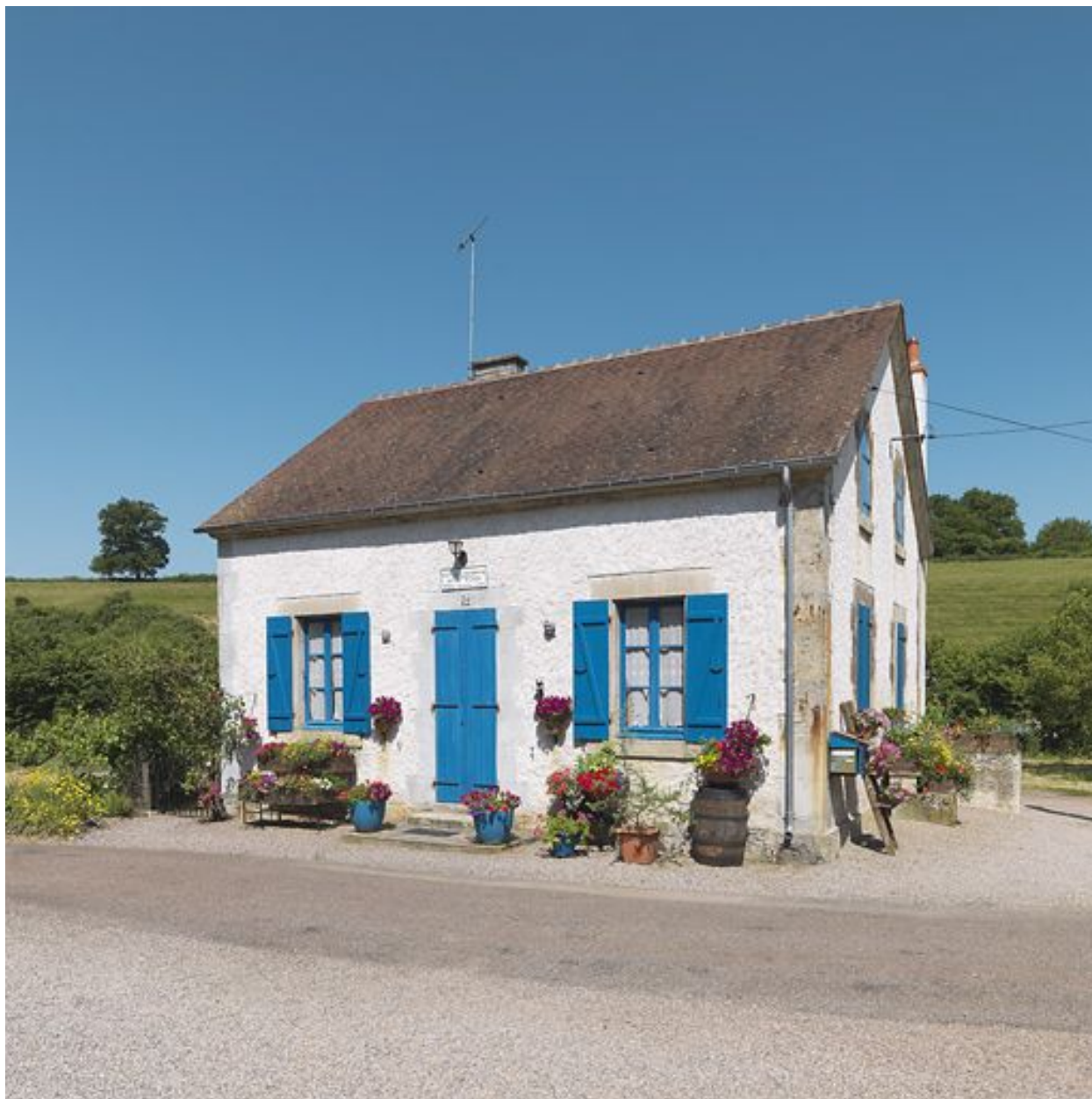
Vue de la maison éclusière de 3/4.
