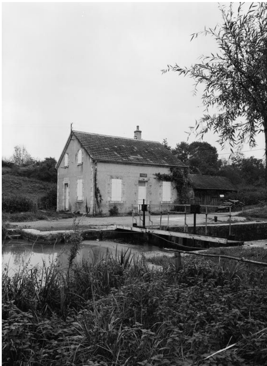
La maison éclusière vue d'amont.
