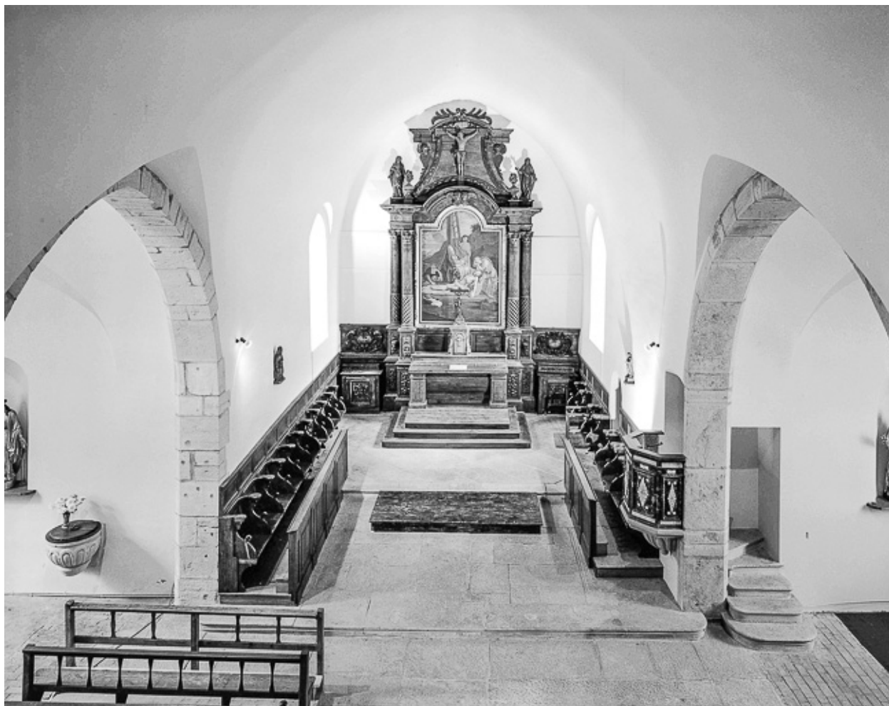
Intérieur : chœur vu depuis la tribune.
