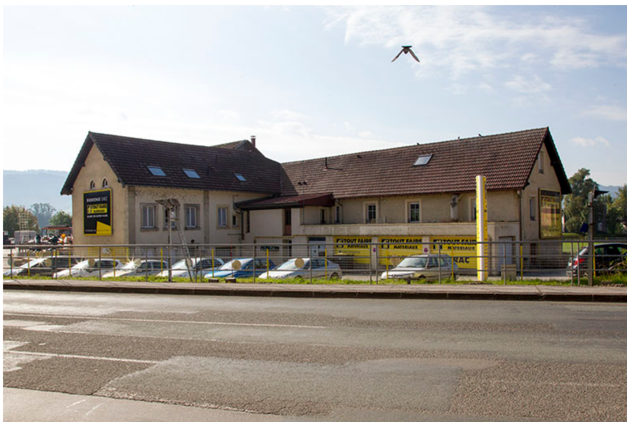
Façades antérieure et latérale droite.
