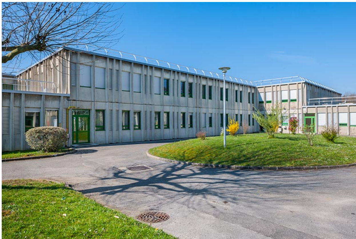
Infirmerie : façades postérieures
