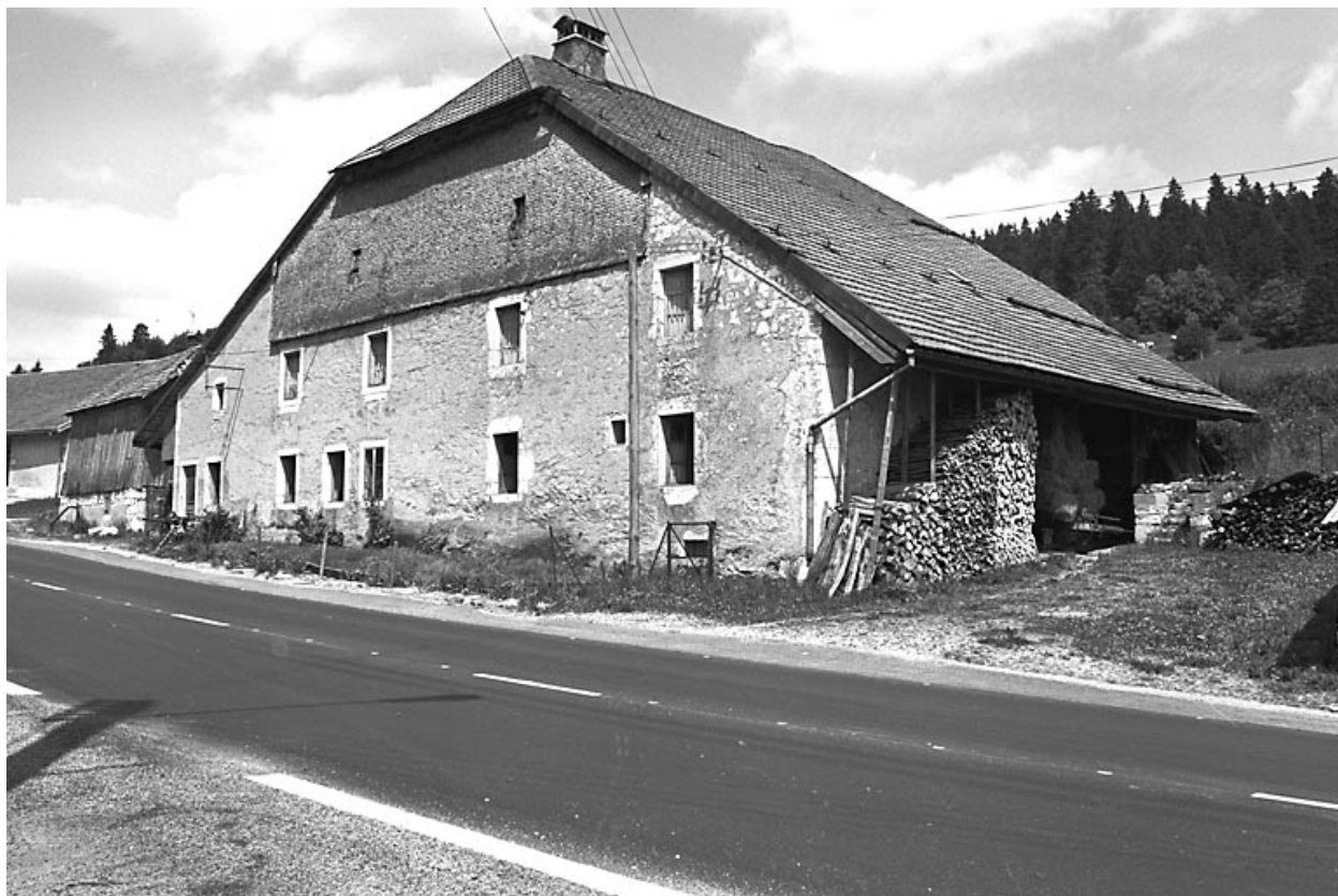
Ferme située impasse de la Source (?).
