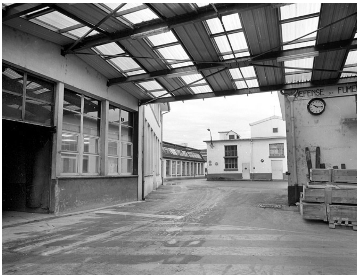
Ateliers de fabrication depuis l'est.
