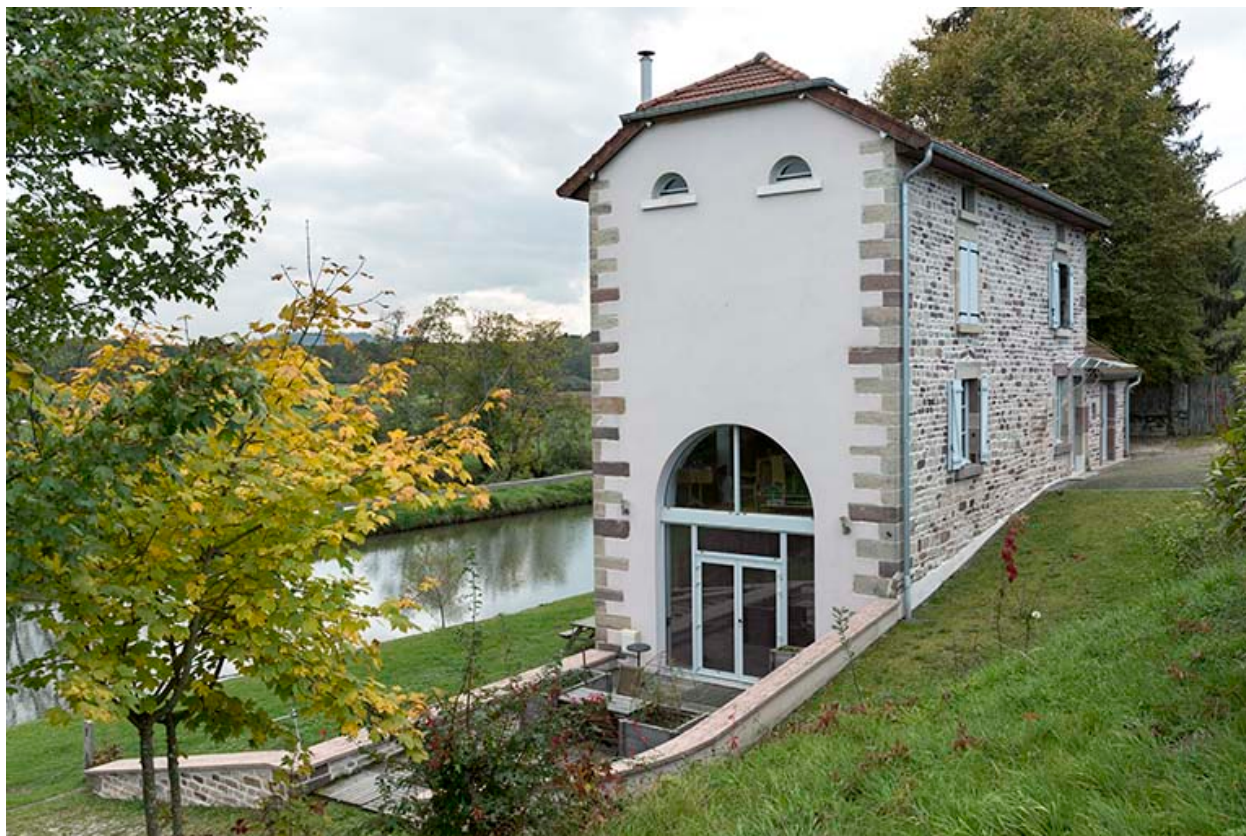
Maison située face au canal, vue latérale (3).
