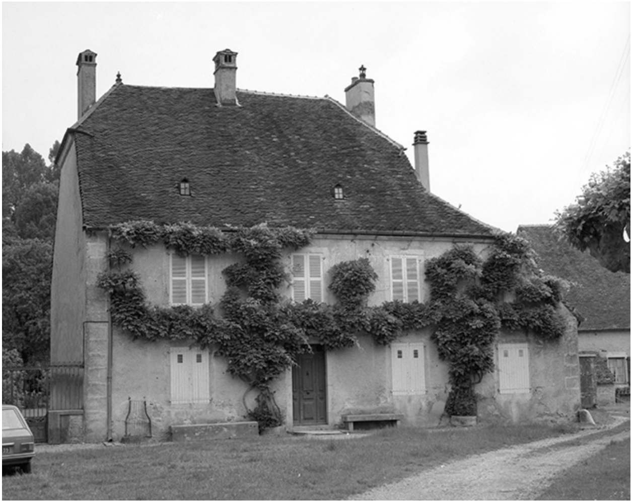
Maison : façade antérieure.
