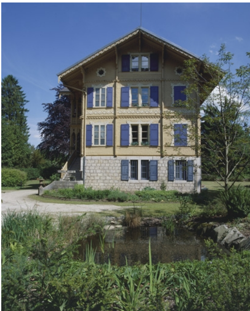
Chalet. Façade ouest.
