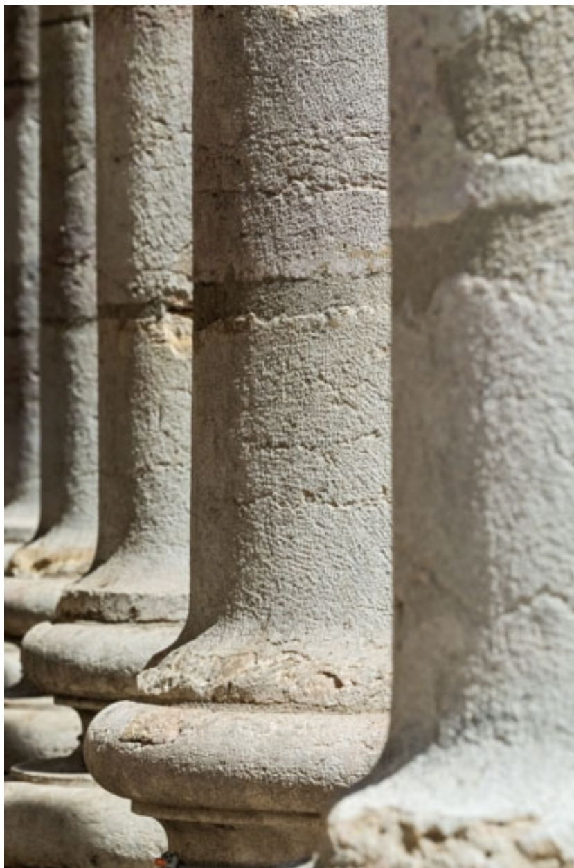
Façade antérieure : base des colonnes.
