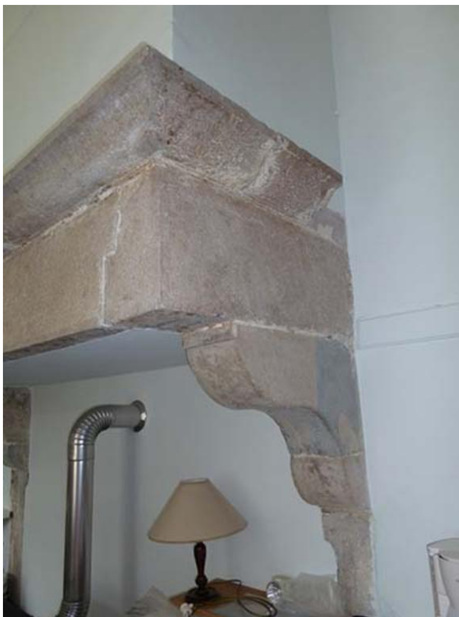
Détail du corbeau
