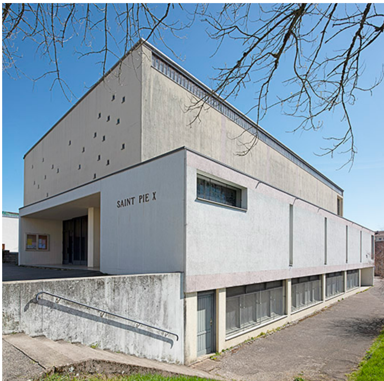
Eglise. Façade antérieure (nord-ouest) et façade sud-ouest.
