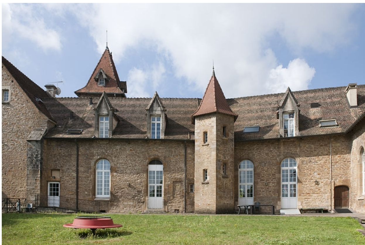
Bâtiment (C), vue d'ensemble côté jardin.
