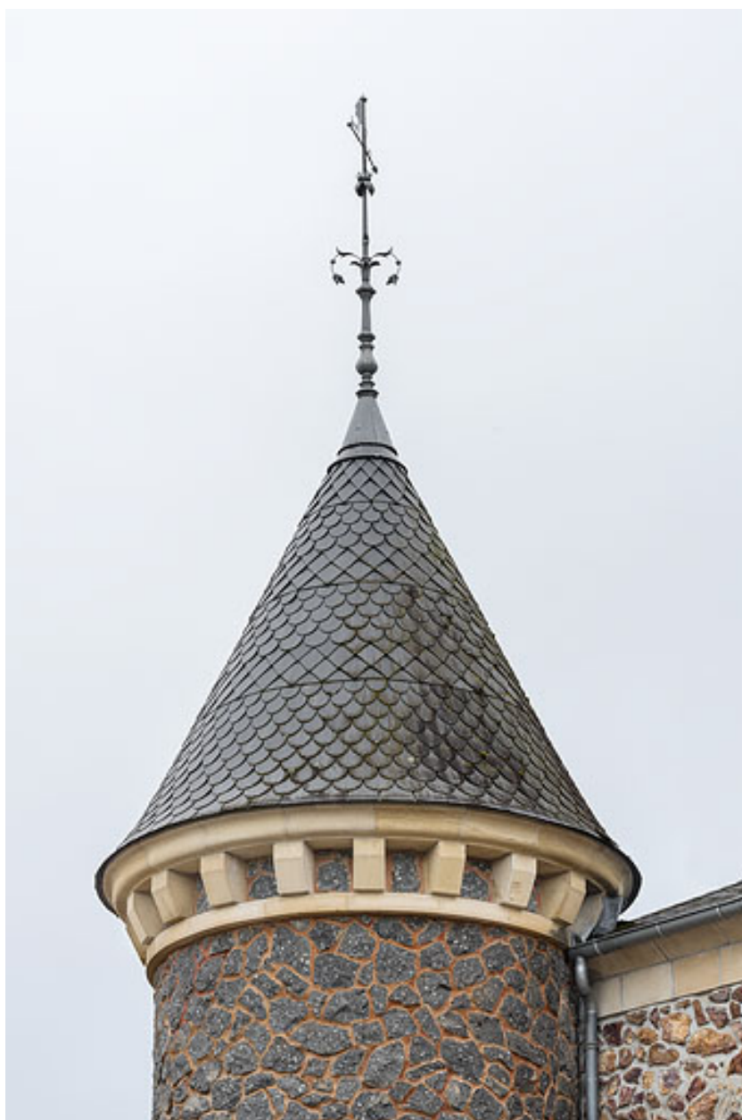
Toiture de la tour de plan circulaire.
