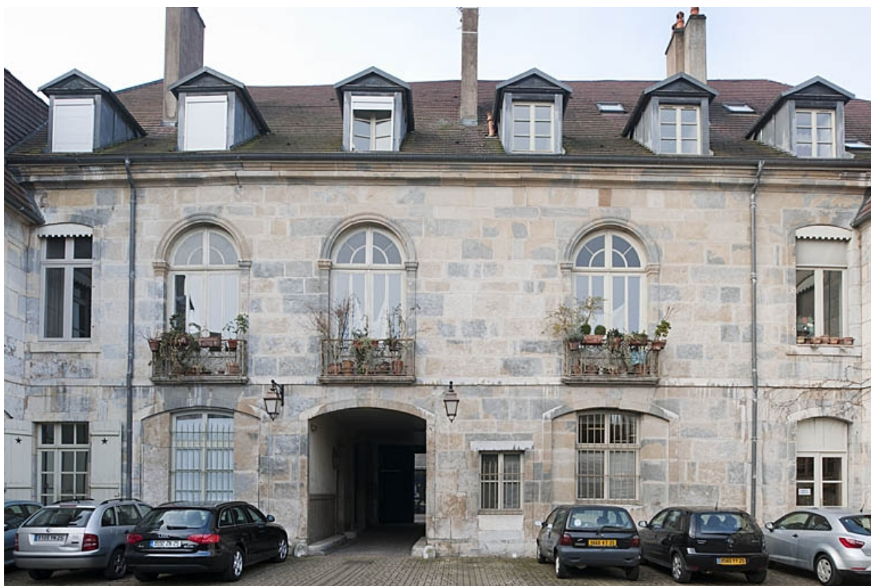
façade postérieure de l'hôtel : de face.
