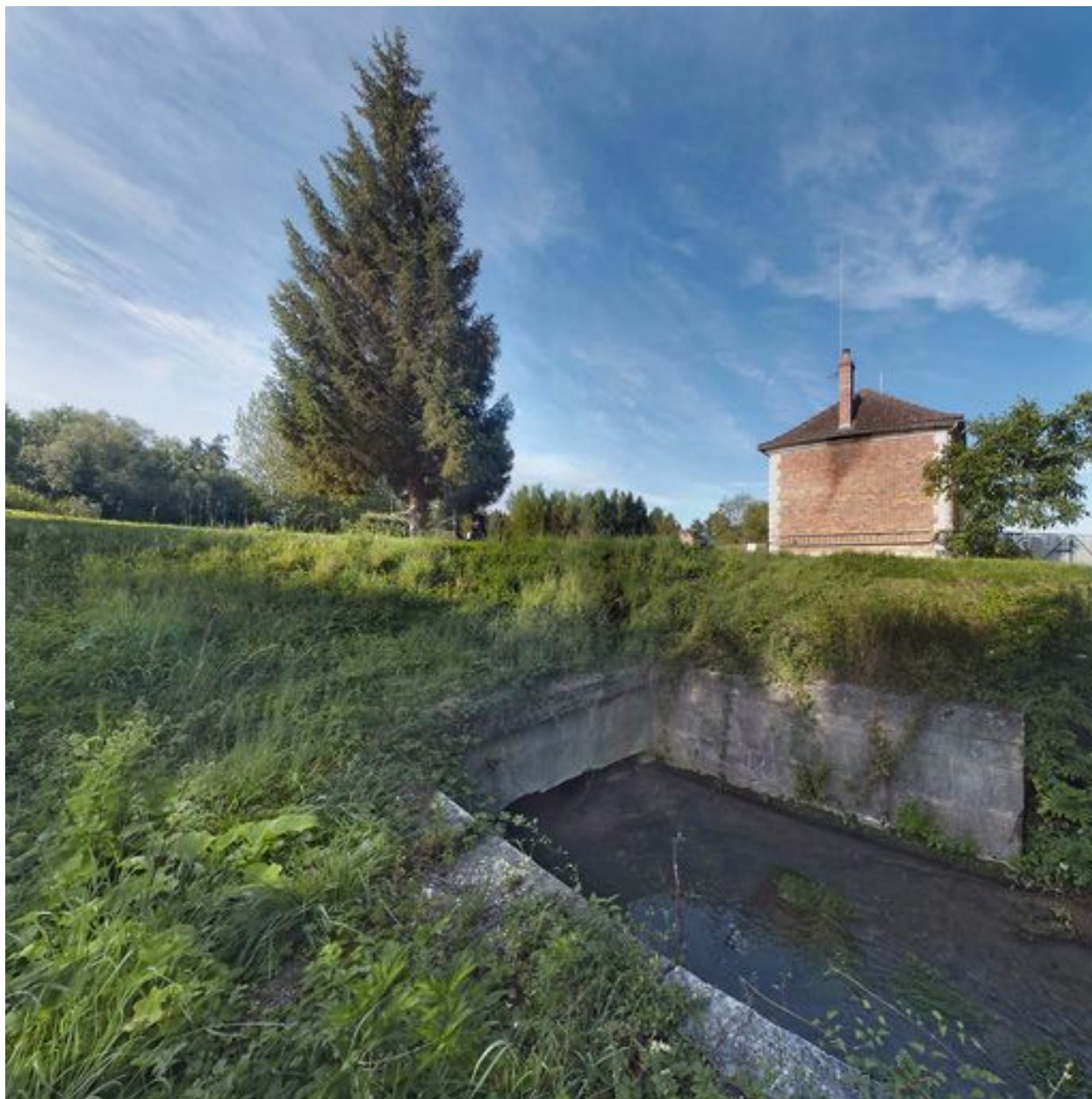
Entrée de l'aqueduc.
