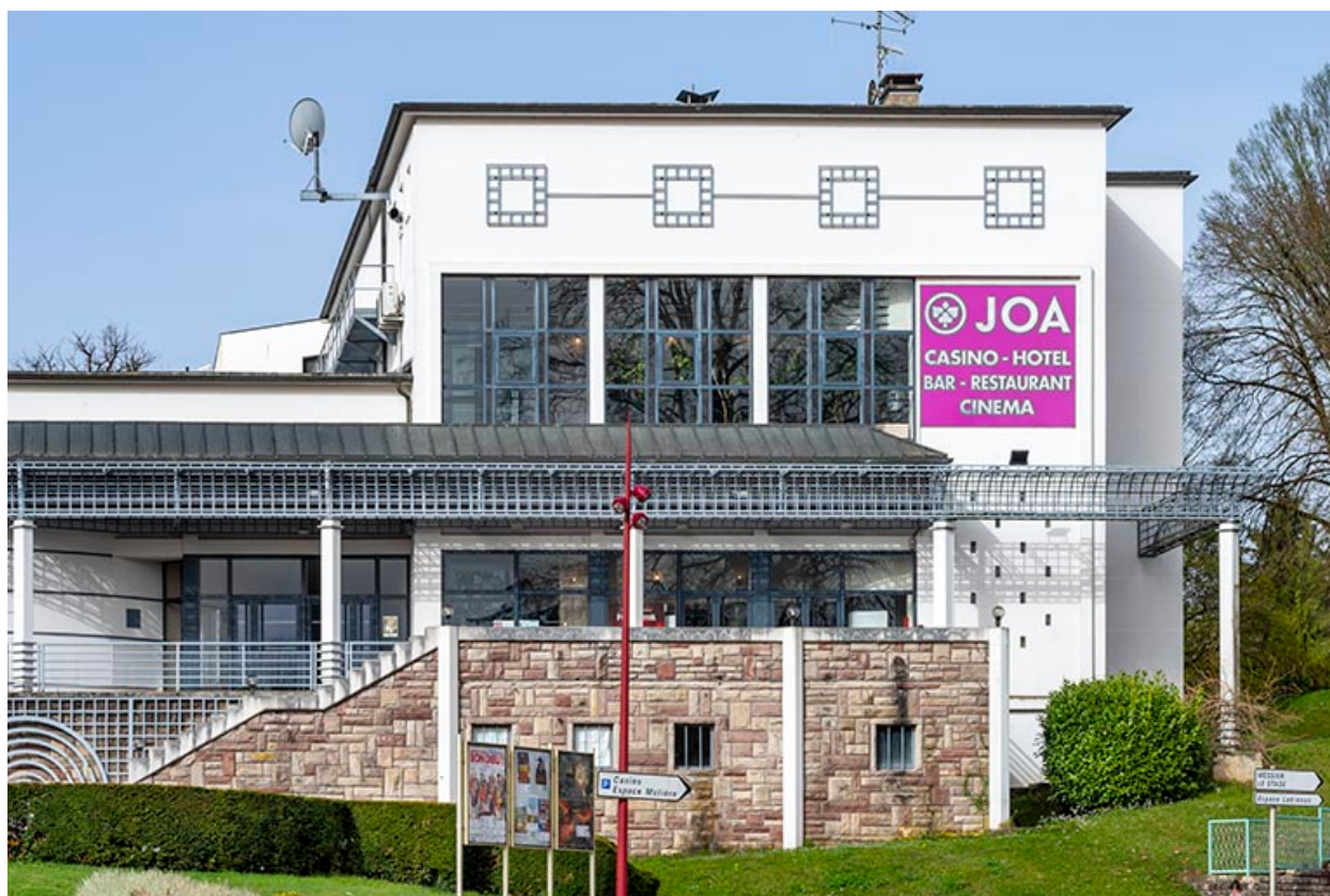
Salle des fêtes, vue depuis l'ouest.
