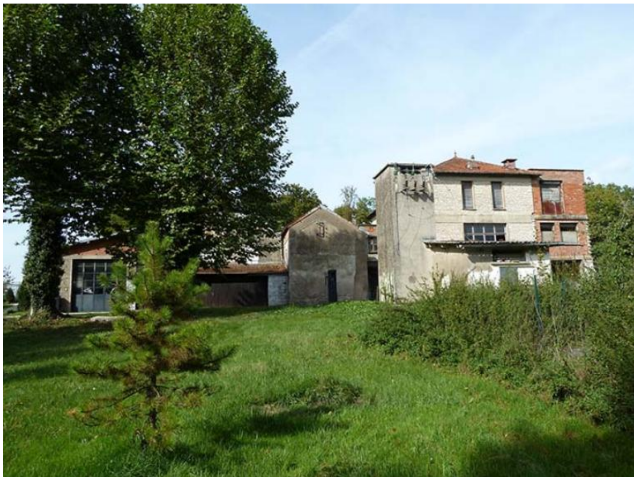
Vue sud de la laiterie
