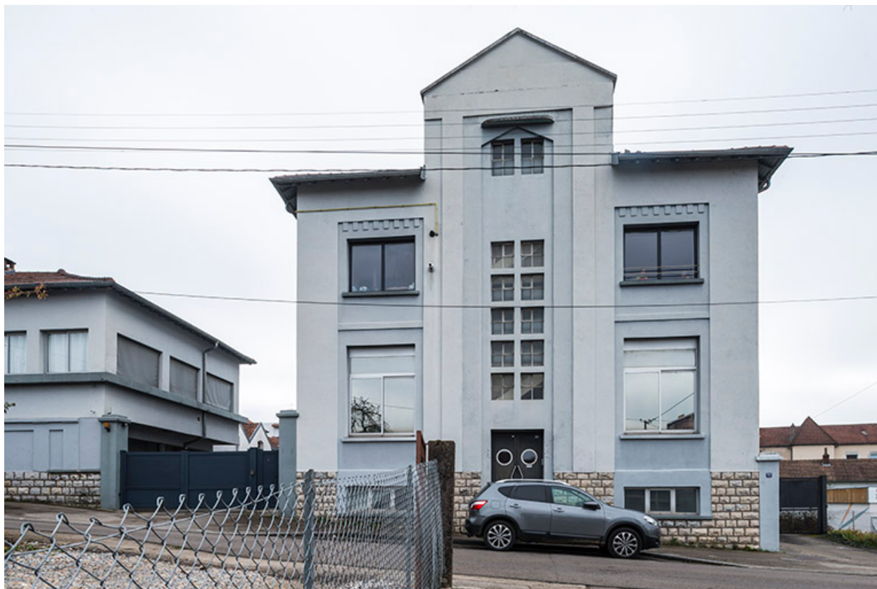
Façade antérieure (les bureaux).
