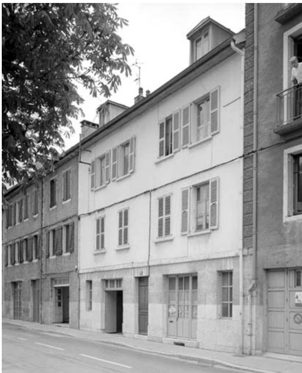
Façade antérieure de l'immeuble.
