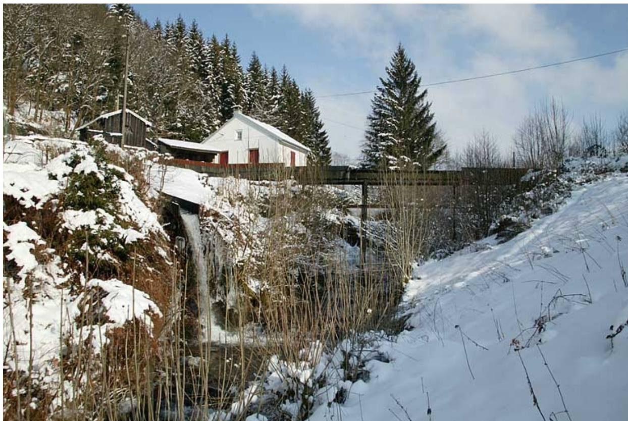
Le déversoir et le canal d'amenée.
