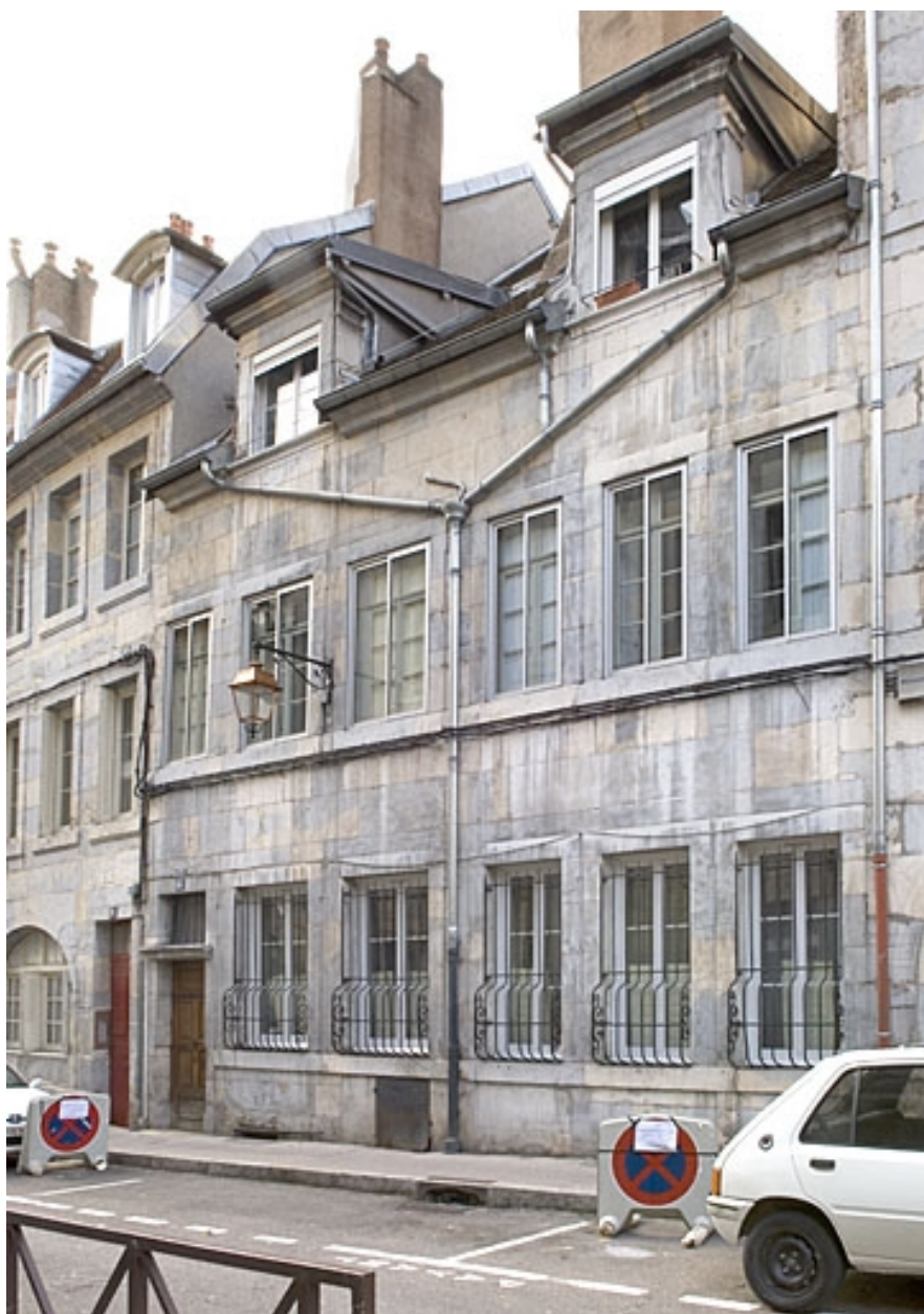
Vue d'ensemble de la façade sur rue.
