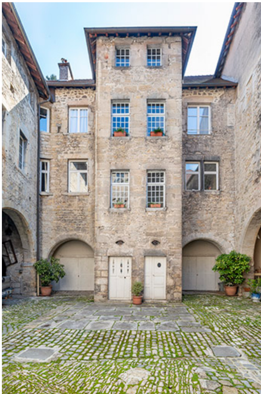
Bâtiment conventuel est. Façade sur cour.
