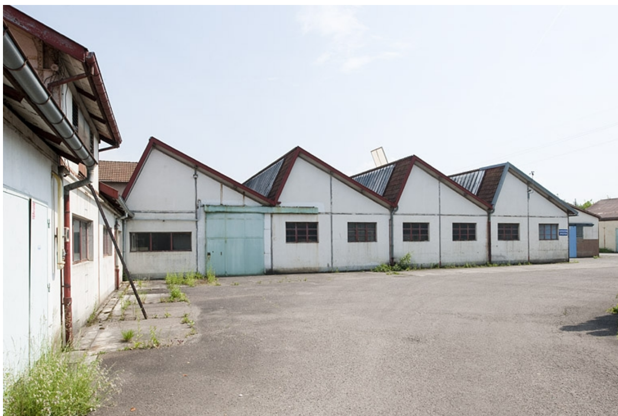
Pignons des shed de l'atelier d'usinage sud.
