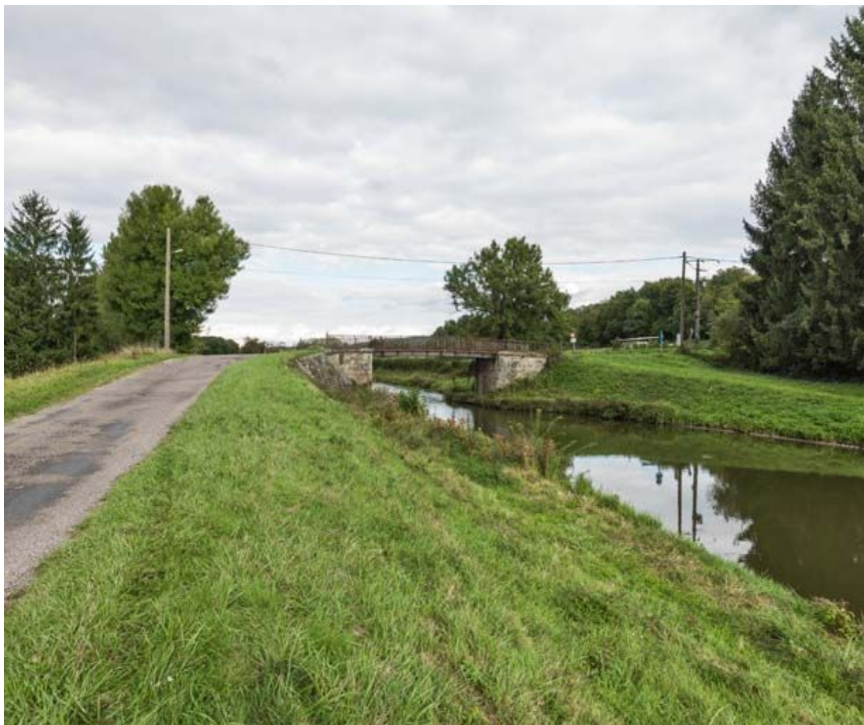
Vue d'ensemble du pont et du site.
